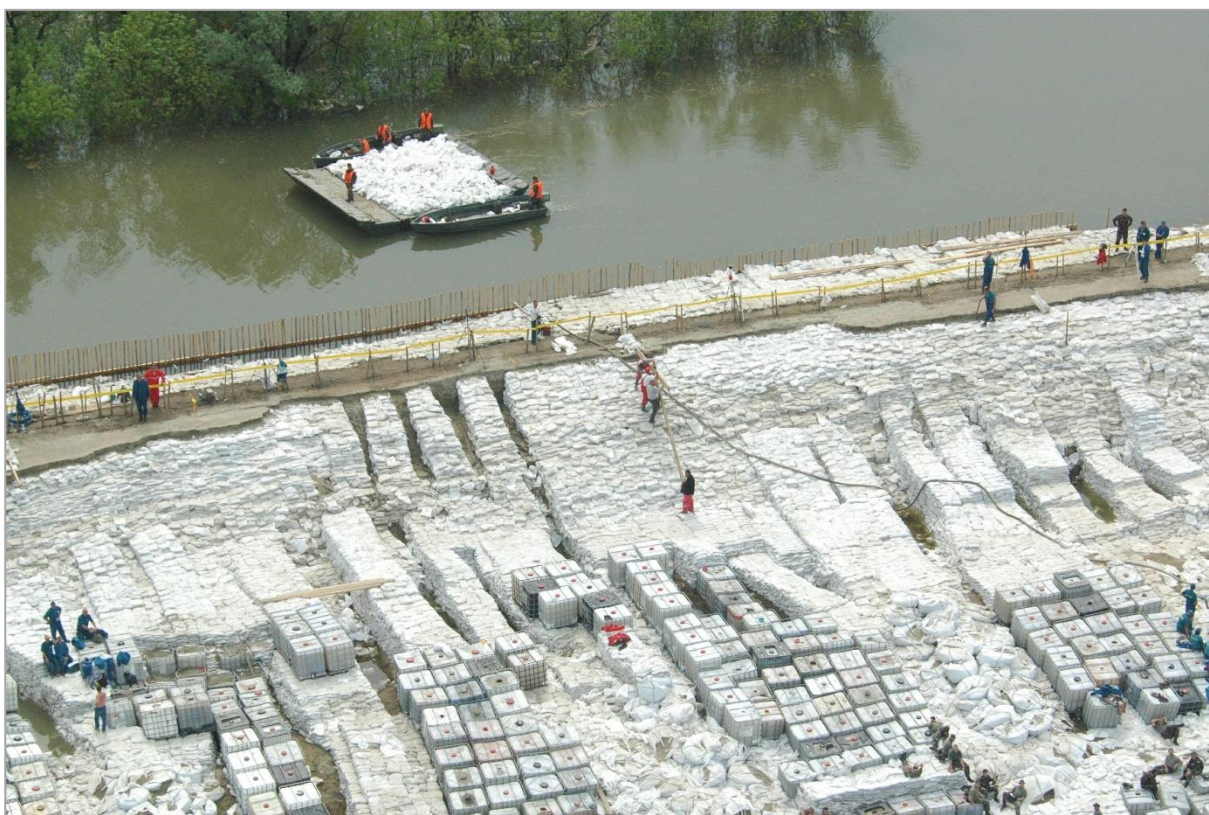
3. kép. A védekezés jelképévé vált "fehér" gát Csongrád-Nagyvér térségében, a Hármas-Körös jobb partján, a tiszai torkolat közelében (Fotó: KÖTIVIZIG)
