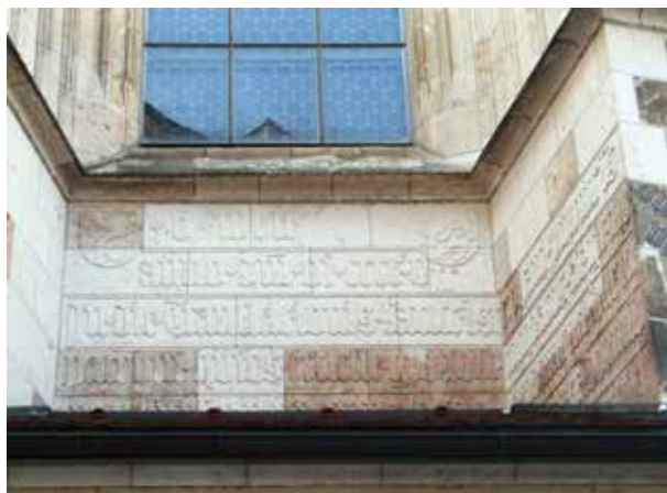
6. Építési felirat a passauzi székesegyház szentélyén Fotó © Lővei Pál, 2010
