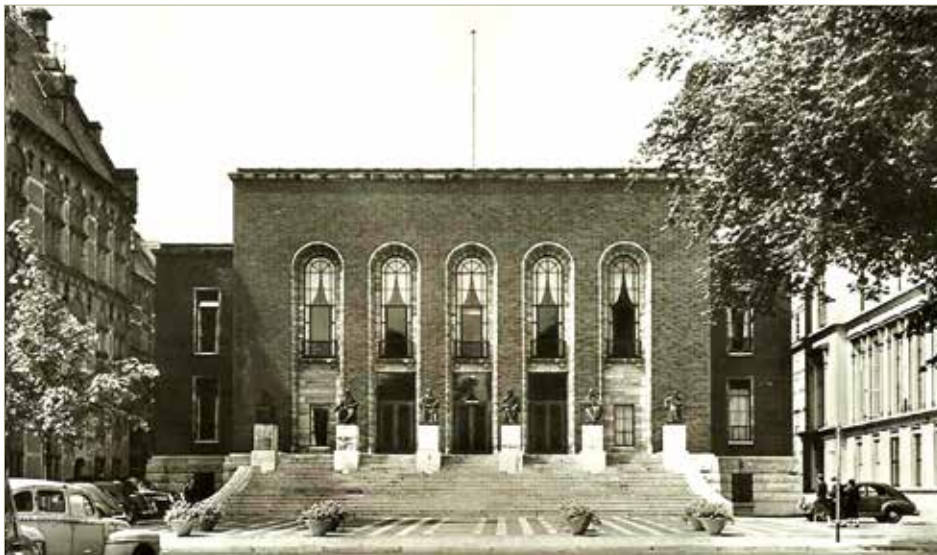
Hollandia Legfelsőbb Bíróságának régi épülete a jogtudósok szobraival. 1930
