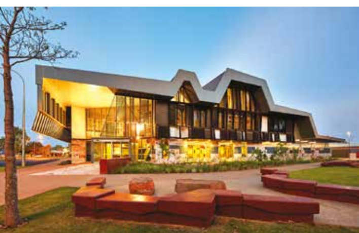
Kununurra bírósága, Ausztrália. Épült 2013 és 2015 között. Tervezte: TAG Architects project és Iredale Pedersen Hook Architects project team
