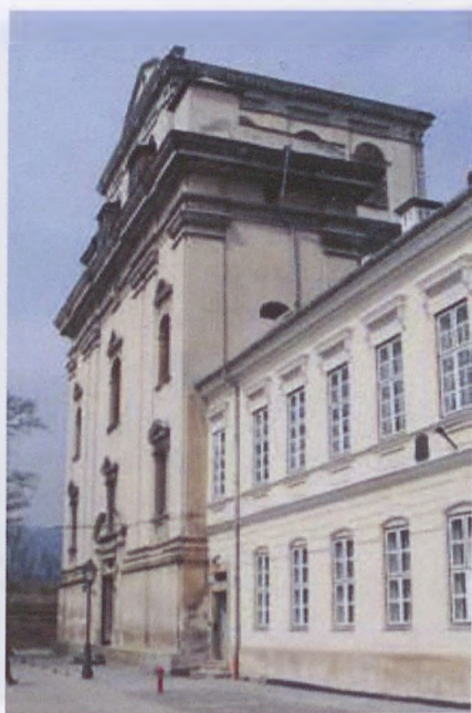
Fig. 2, ...son bâtiment, dans une ancienne église des Trinitaires
