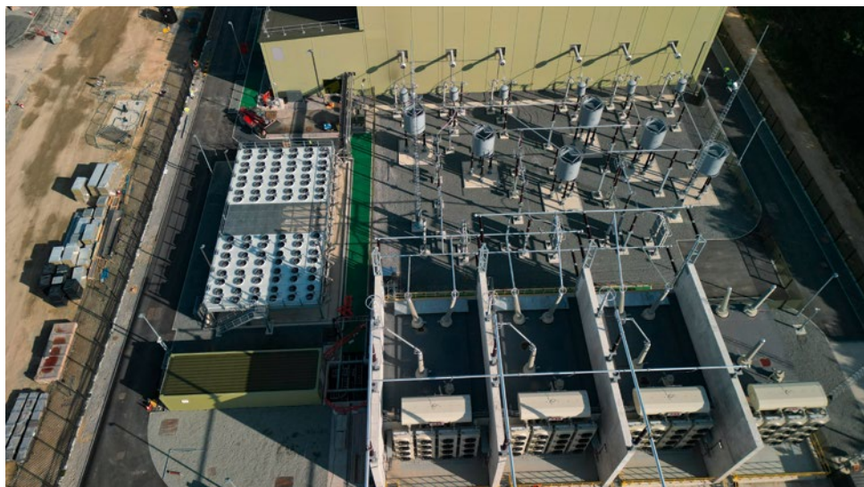
10. ábra. A Dogger Bank tengeri szélfarm parti konverterállomása (Kelet-Yorkshire, UK), amely a szélturbinák által termelt villamos energiát HVDC-ről HVAC-ra alakítja át.
