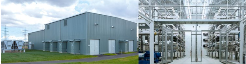
11. ábra. Az első GFM-képességű STATCOM megvalósítása az Amprion Grid hálózatban 2023 Forrás: ENTSO-E (2025)
