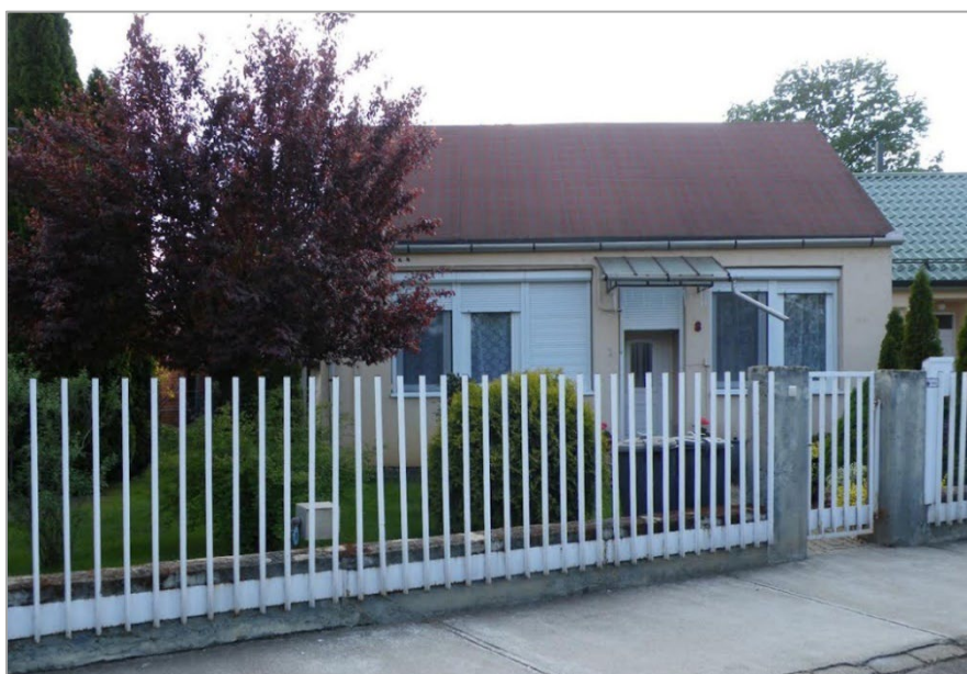
Lakóháza a Flinston telepen Jászberényben
