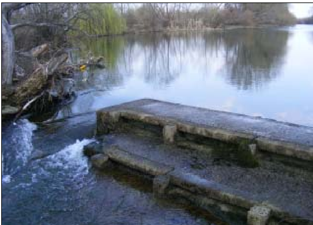
13. ábra A gátest balparti bekötése, az előregyártott betonelemek jó állapotban vannak
