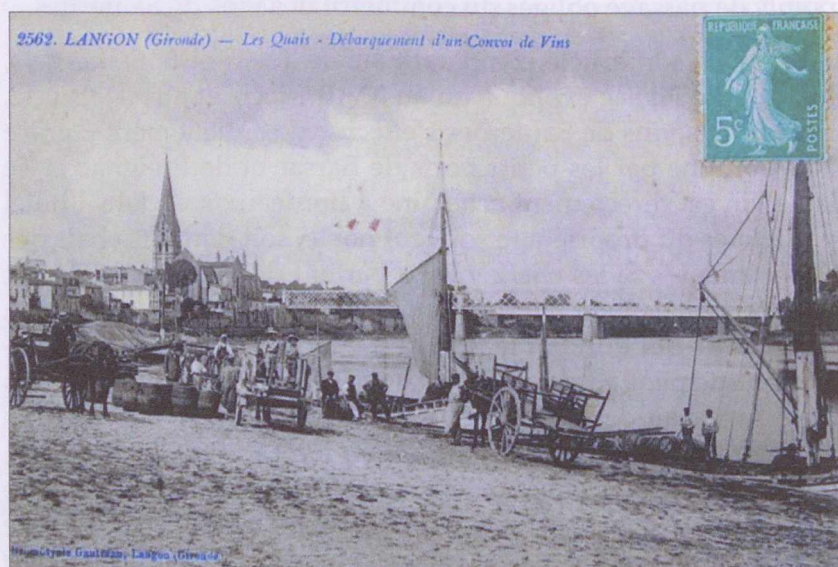
Figure 2. Déchargement d'un convoi de vins sur le port de Langon, début XX e siècle
