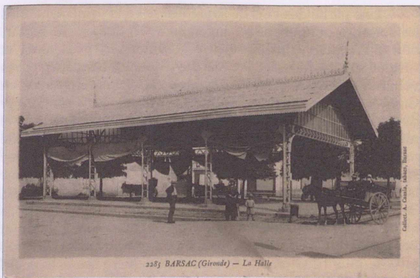
Figure 4. Halle de Barsac, au début du XX e siècle
