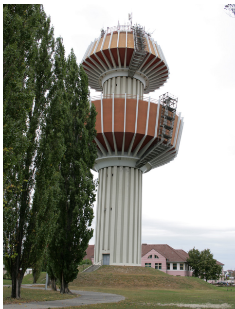
16. ábra. Győr, Marcalvárosi víztorony
