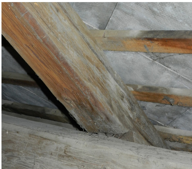
12. ábra. Szaru-falpszelemen, szétcsúszott kapcsolat
