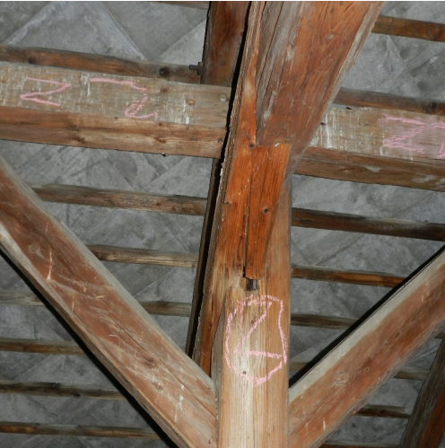
13. ábra. Oszlop–ferdetám, szétcsúszott csomópont
