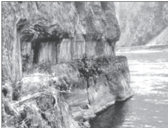
Abb. 39: Die Reste des Felsweges auf der via Traiana und die Rekonstruktion der Holzkonstruktion des Weges. (GABRIČEVIČ 1972; PETROVIĆ 1997)
