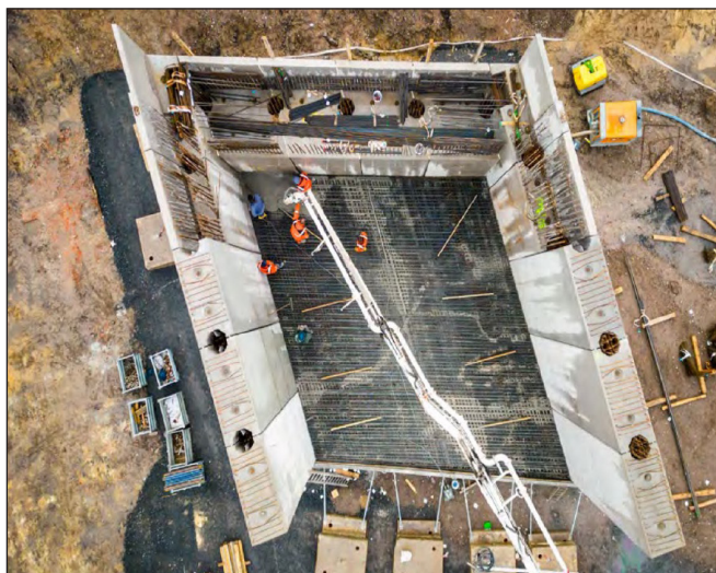
4. ábra: Alépítmények 1 m vastag előregyártott falelemei az együttdolgoztató kapcsolat betonozása előtt (Brücken 2024: 17)
