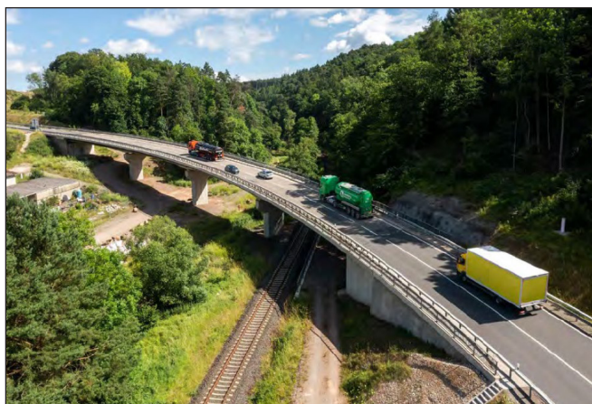
7. ábra: A kész híd látképe (Brücken 2024: 197)
