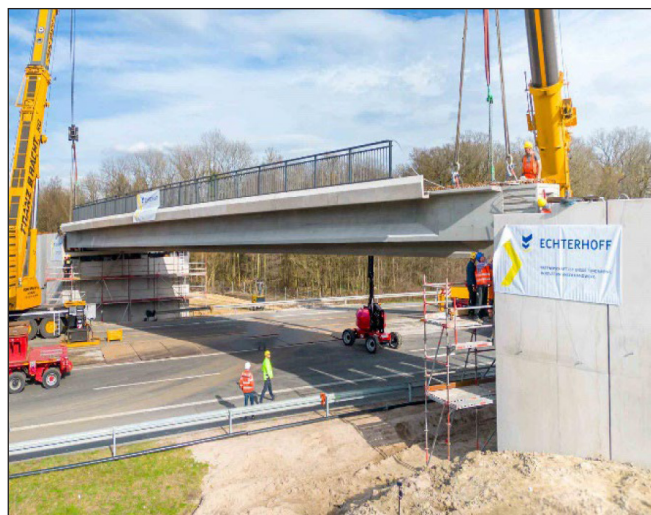
6. ábra: Szélső hídgerenda beemelése az acél szegélyzsálatat és korláttal együtt (Brücken 2024: 18)
