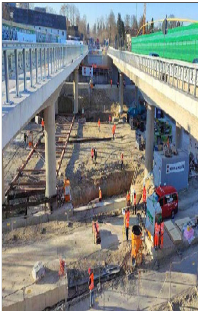
14. ábra: A keresztirányú mozgásra előkészített híd (Brücken 2023: 63)
