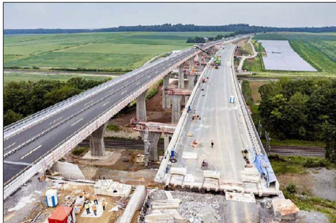
17. ábra: Építési állapot az ideiglenes támaszokról való áttolással előtt (Brücken 2023: 44)
