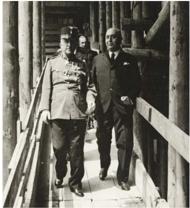
183. kép. József Ágost főherceg, az Akadémia elnöke megtekinti a budapesti Vigyázó-palota helyén épülő új akadémiai ingatlant...
