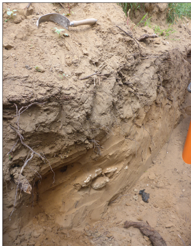
4. kép: Kövek a lecsúszott homokos rétegben az épülettől délre, a csatorna árkában (Fotó: Gyenes Gábor)
