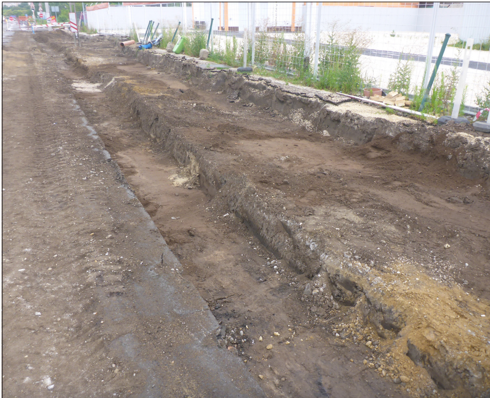
3. kép: A Nádor utcától a Körvasút sor felé eső járda alapozása és a szegélykövezéshez leszedett felület tisztítás közben (Fotó: Gyenes Gábor)
