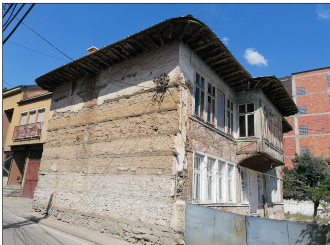
12–13. kép. A szolnoki palota közeli párhuzama egy kőlabazatú, égetetlen agyagtéglából készült U alakú falazattal rendelkező emeletes épület. Eredetileg nyitott, faoszlopos szofája volt, amit utólag átépítettek: ablakokat és konzolosan kiugratott zárterkélyt létesítettek a helyén. Pristina, Afrim Loxha utca 65., Koszovó, 18. század (fotó: Kertész R., 2024)
