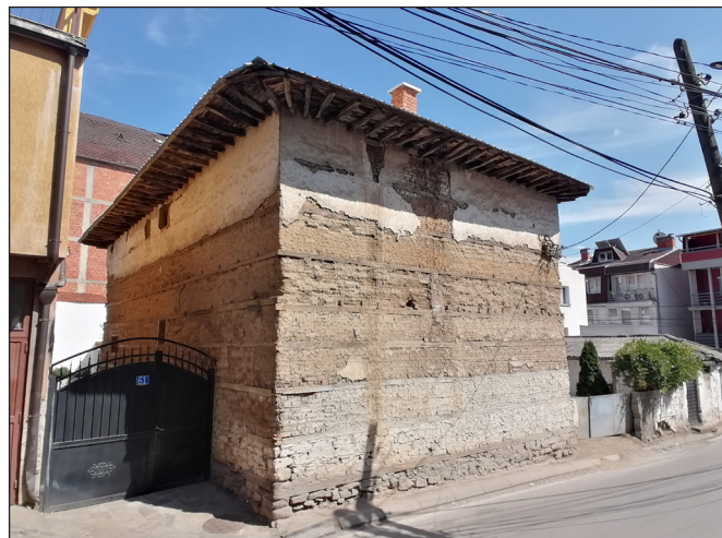
12–13. kép. A szolnoki palota közeli párhuzama egy kőlabazatú, égetetlen agyagtéglából készült U alakú falazattal rendelkező emeletes épület. Eredetileg nyitott, faoszlopos szofája volt, amit utólag átépítettek: ablakokat és konzolosan kiugratott zárterkélyt létesítettek a helyén. Pristina, Afrim Loxha utca 65., Koszovó, 18. század (fotó: Kertész R., 2024)
