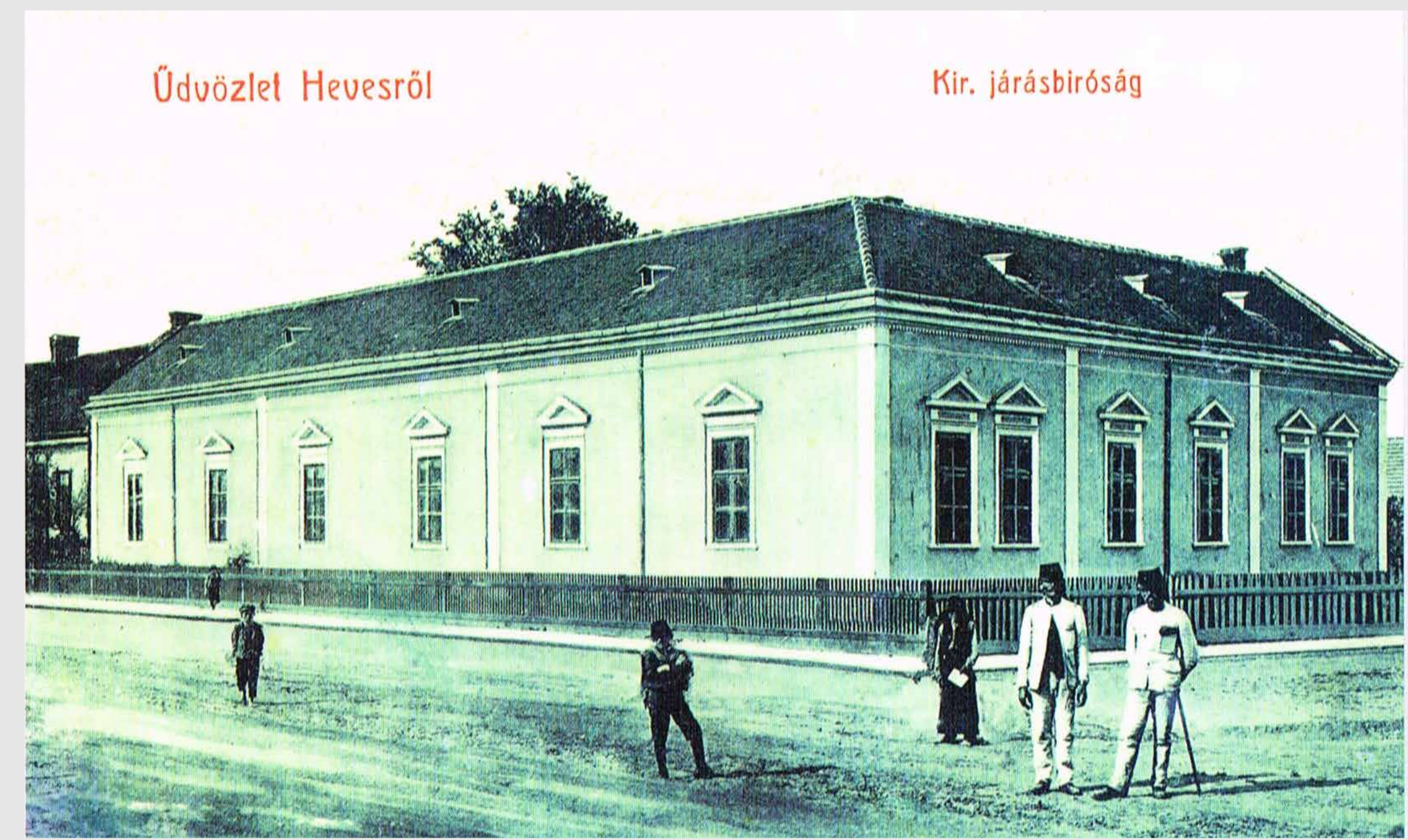
A Hevesi Királyi Járásbírósg 1880-ban épült földszintes épülete. (Bartalos József és Szombath Tibor gyűjteménye)
