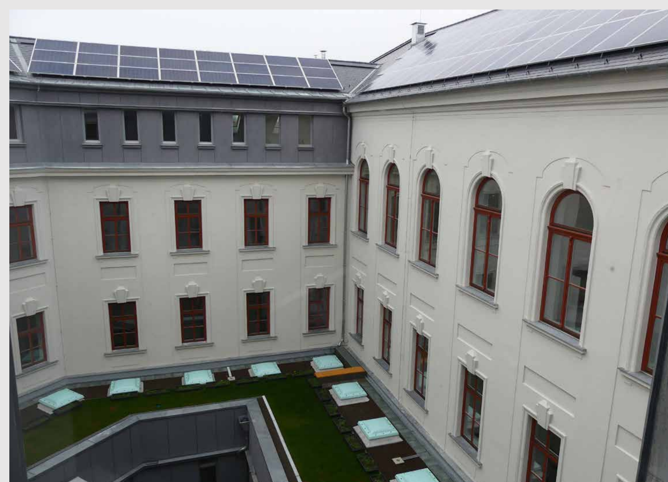
Az elkészült épület belső udvari bővítése. (Megyeri-Pálffi Zoltán fotója)
