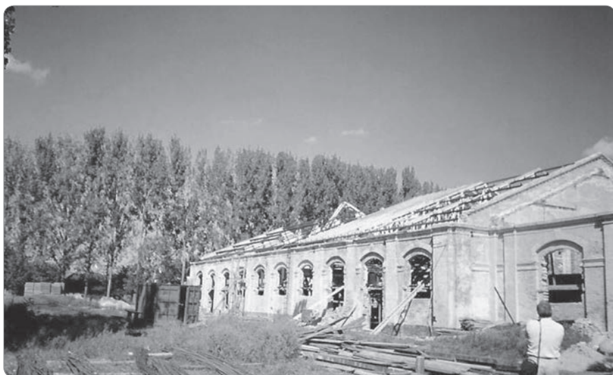
7. kép. A Lovarda a felújítás alatt. 41
