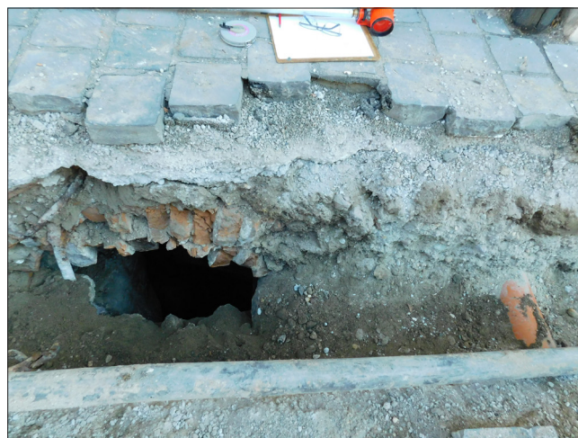
2. kép: Pince jelentkezése a mai járda alatt (Fotó: Tóth Anikó)
