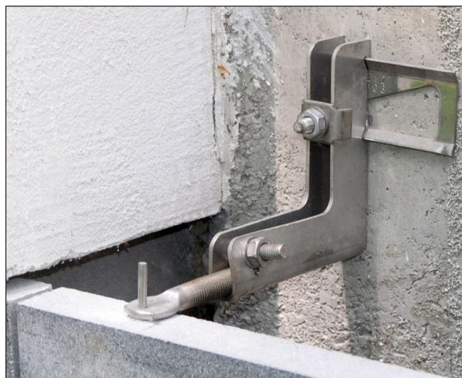
9. ábra: Átszellőztetett kőlap burkolatú homlokzat építés közben (Fotó: HALFEN)
