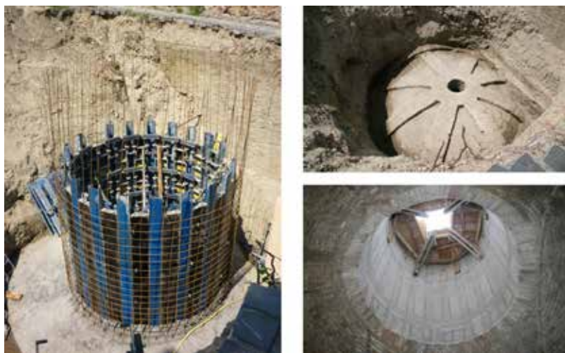
A lift áttörés építési munkái, az áttört boltozat és az akna
