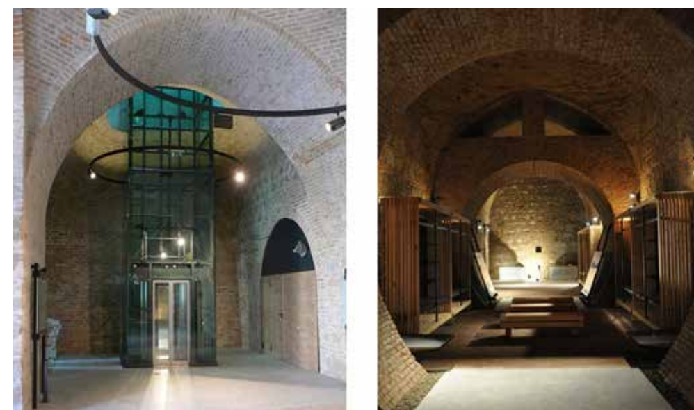
A Főszékesegyház és Lelkiségi Központ közötti kapcsolatot a pincerendszeren keresztül, lift beépítésével oldották meg. A korszerű gépészeti és villamos berendezéseket védőcsatornába tervezett rendszerekkel kötötték össze. A megjelenés fényét a belső rész számos és nivós építészeti megoldása emelte.
