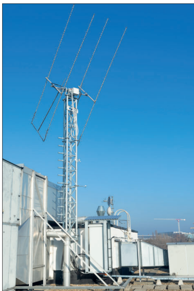
5. ábra. Az UHF frekvenciasávú földi állomás antennarendszere [21]
