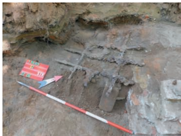
16. ábra. A torony északi falán lévő ablak kiberult rácsa (a letörött részeket a fotóhoz visszaállítottuk)
