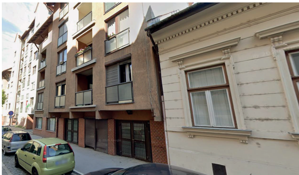
5. ábra: A településképbe nem illeszkedő új építésű épület a VIII. kerületben
