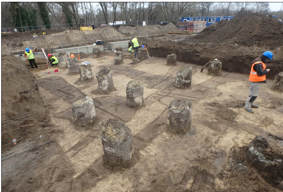
2. kép: A bejelentés nélküli cölöpözés nagyban nehezítette a feltárást (Fotó: Tóth Farkas Márton)
