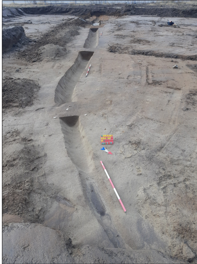
3. kép: Az építési területen keresztülfutó árok a feltárás után (Fotó: Olgyay János)
