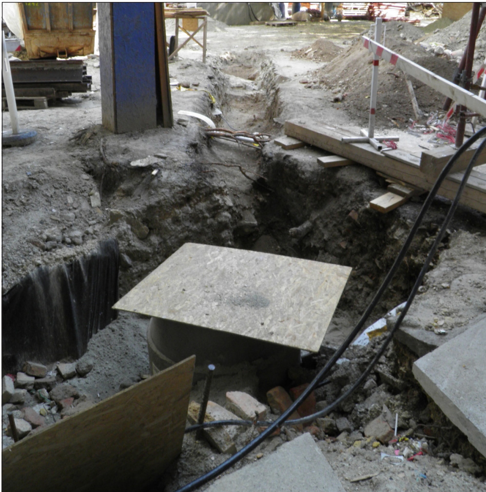
3. kép: Az Újvilág kertben ásott közműárok (Fotó: Magyar Eszter) Fig. 3. Utility trench excavated in the Újvilág Garden (Photo by Eszter Magyar)
