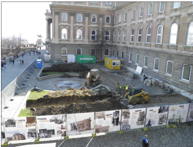
4. kép: A kibontott vízvezeték-árok (Fotó: Magyar Károly)
