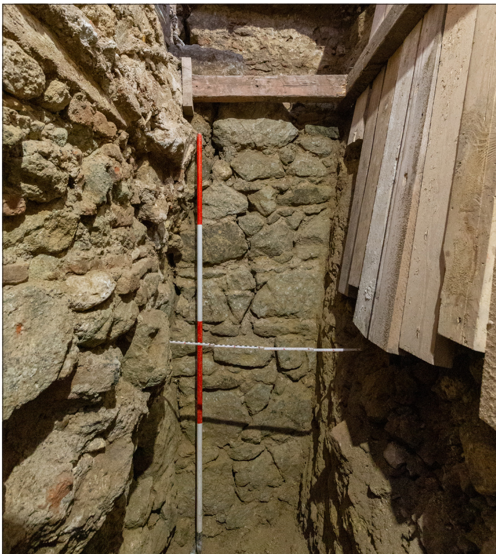
2. kép: Várfalak csatlakozása a Déli zártkert délkeleti sarkában (Fotó: Keppel Ákos) Fig. 2. Junction of the castle walls at the southeastern corner of the Southern Enclosed Garden (Photo by Ákos Keppel)
