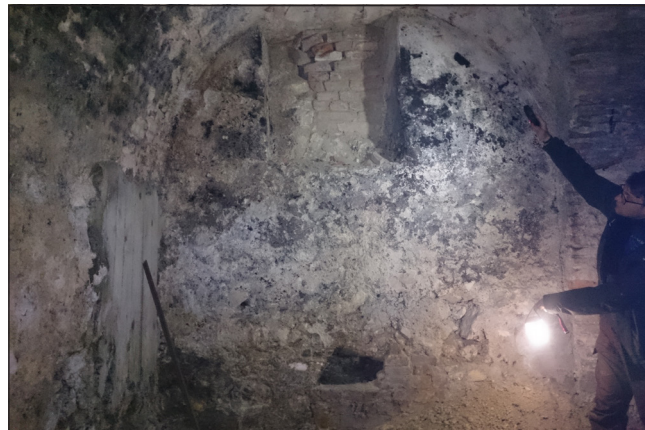
4. kép: Az északi pince északi falában a középkori ajtónyílás (Fotó: Benda Judit)
