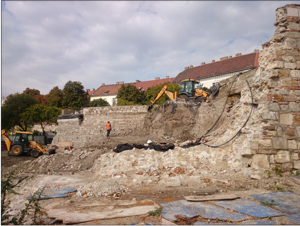
1. kép: A 16. századi rondella műemlékileg helyreállított falának bontása és az 50-es évekbeli feltöltés letermelése (Fotó: Benda Judit)
