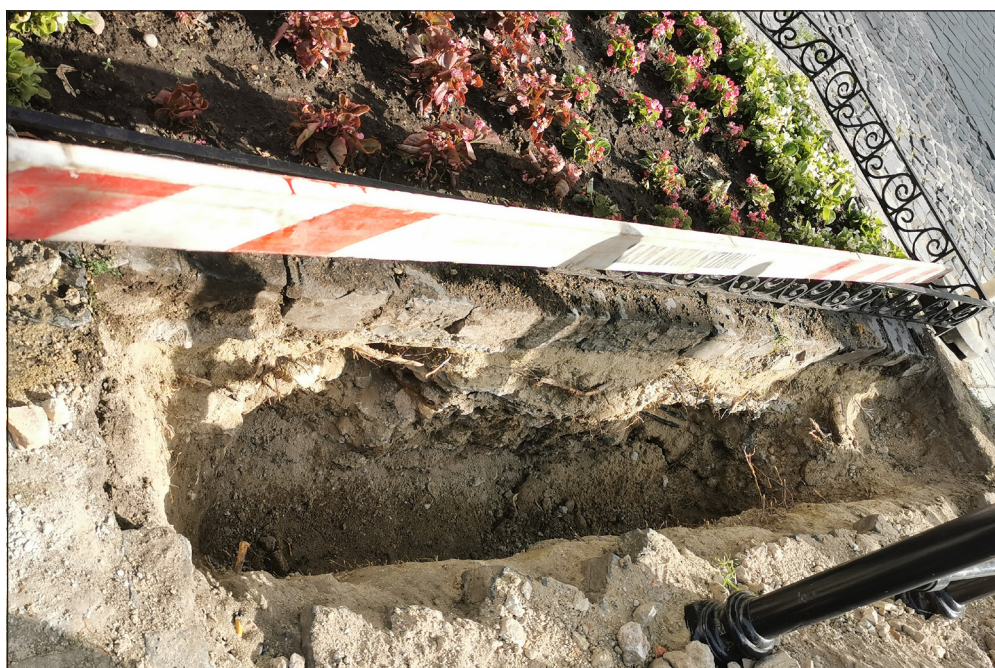
1. kép: A kiásott árok dél felől (Fotó: Benda Judit)
