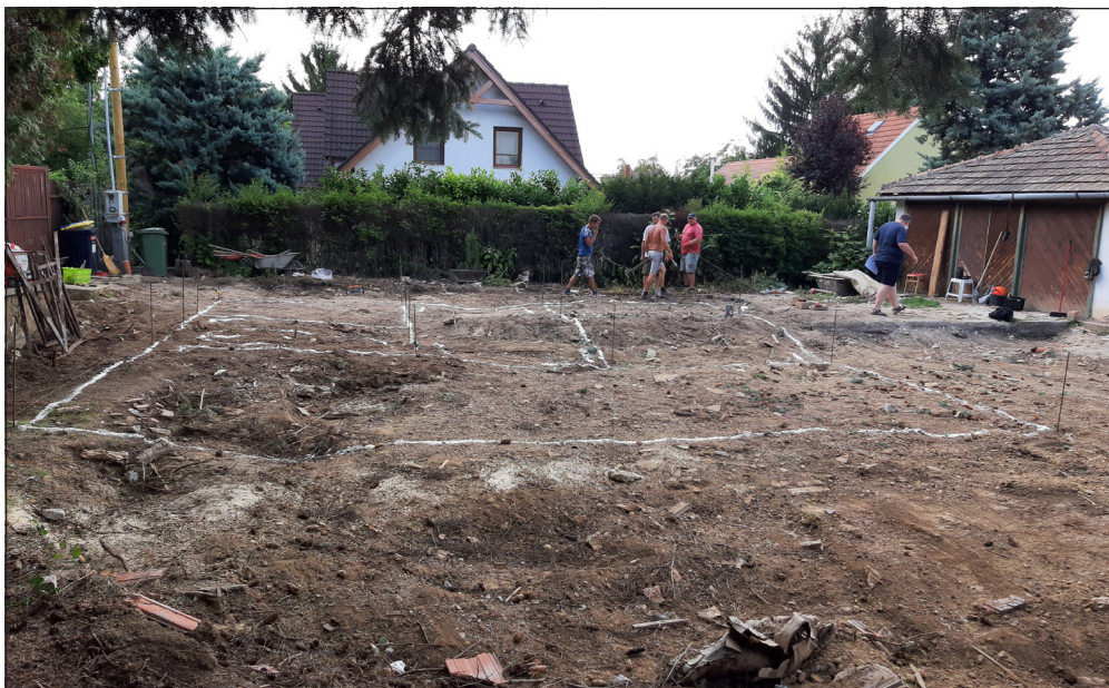
1. kép: Az építési telek a kijelölt alapárkokkal (Fotó: Olgyay János)
