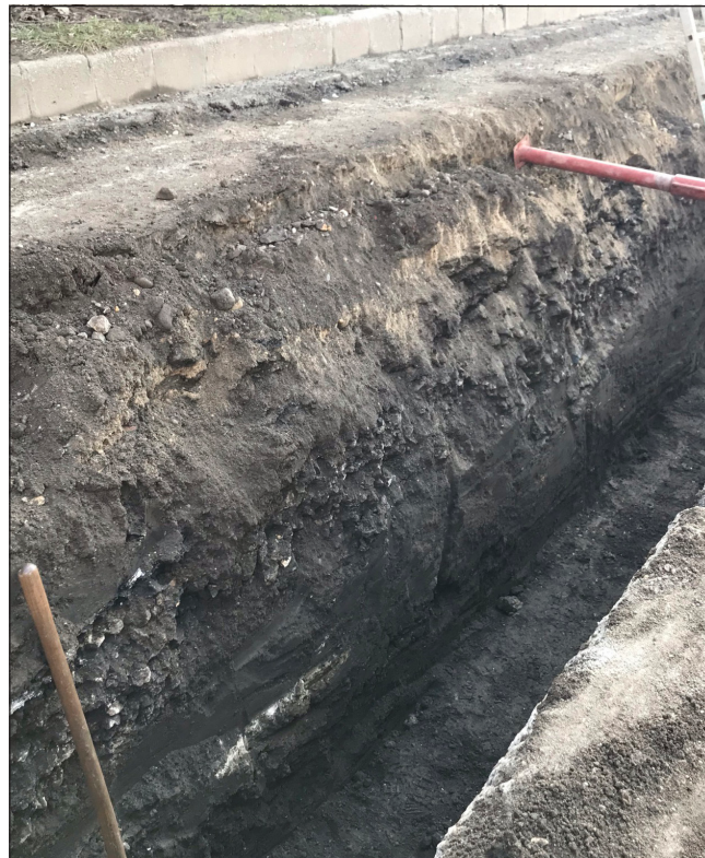
2. kép: A közműárok falában jelentkező rétegsor (Fotó: Hajdu Barbara)
