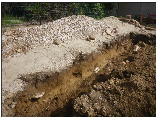
1. kép: A garázs nyugati alapárka (Fotó: Gyenes Gábor) Fig. 1. Western foundation trench of the garage (Photo by Gábor Gyenes)
