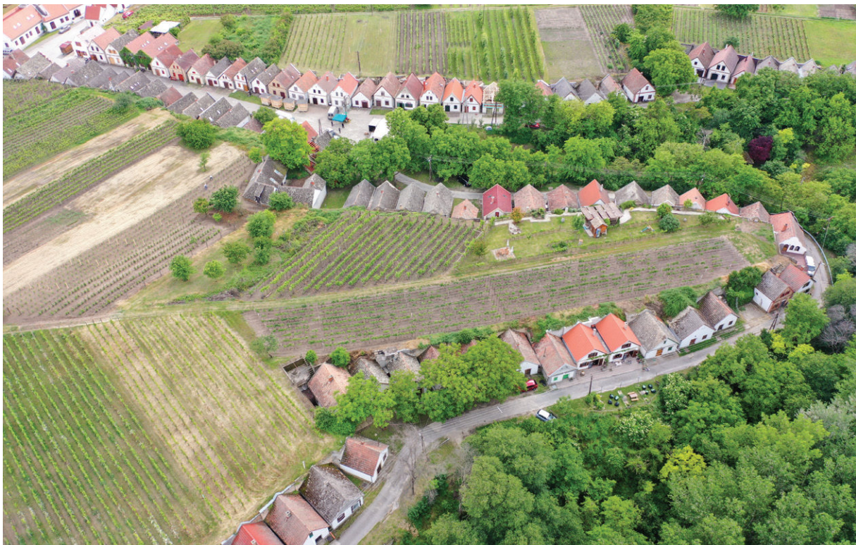
Figure 6 – Place of the former church from the northwest (Photo: István Pányá) 6. kép – Az egykori templom helye északnyugatról
