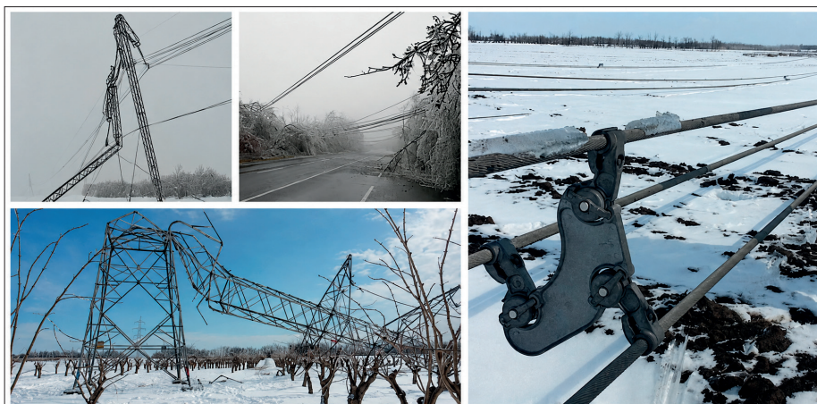
4. ábra. Szélsőséges jégteher miatt sérült távvezetékek a MAVIR hálózaton (2013. március és 2014. december)
