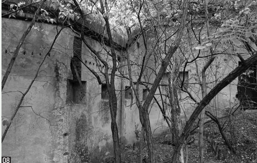
06-08 Jelenlegi állapot: a betonszerkezet megmaradt, a lőrészeket lezárták, az acélszerkezetek eltűntek
