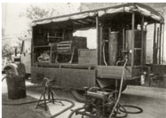
9. ÁBRA. Tábori fürdető gépkocsi berendezéseinek telepítése [3]
