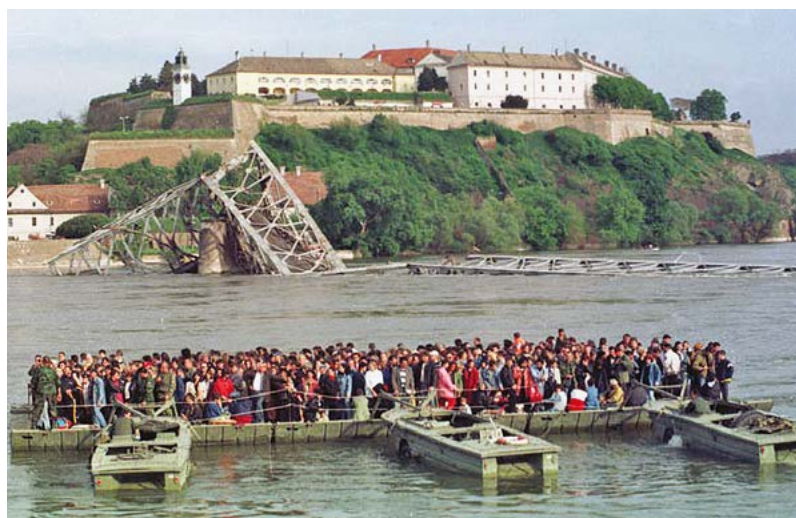
3. ÁBRA. Katonai szalaghíd civilkomponensben a híd nélküli maradt városban [15]
