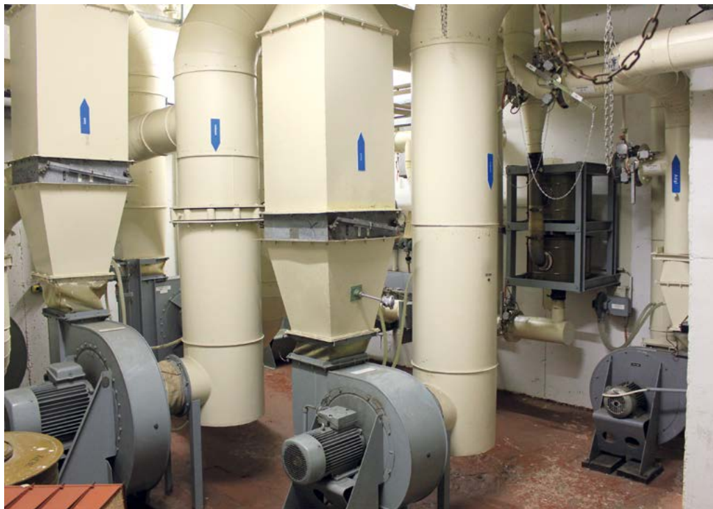
6. ÁBRA. A szellőztető gépházban működő ventilátorok feladata volt a külső, friss levegő beszívása a gázbiztos térbe, illetve a belső levegő keringtetése, az adott üzemmódnak megfelelően. A légszatórnákon kék nyilakkal jelölték a levegő útját (A szerző felvétele)
