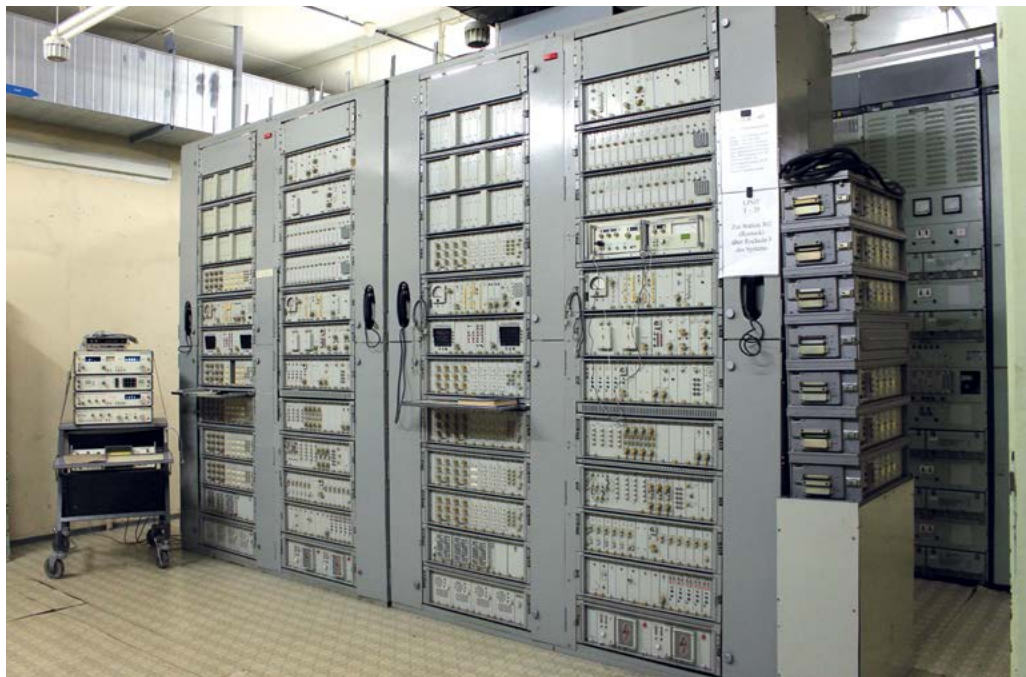
5. ÁBRA. Impozáns, szinte szobányi méretű az „Azúr - 60 SzR” típusú csatornaképző berendezés, amely biztosította a digitális adatátviteli csatornák létrehozását, rendezését (A szerző felvétele)
