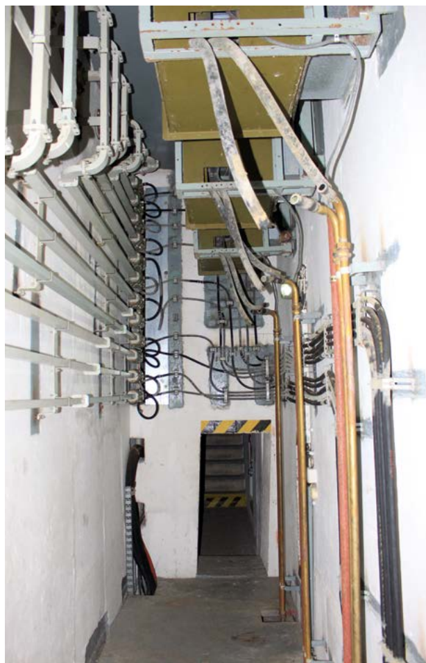
4. ÁBRA. Falra szerelt, nyomás alatt lévő csőtápvonalak vezetnek az adóktól az antennatornyok talpzataiig, majd ott egy földemáttörésen keresztül fel az antennákhoz (A szerző felvétele)
