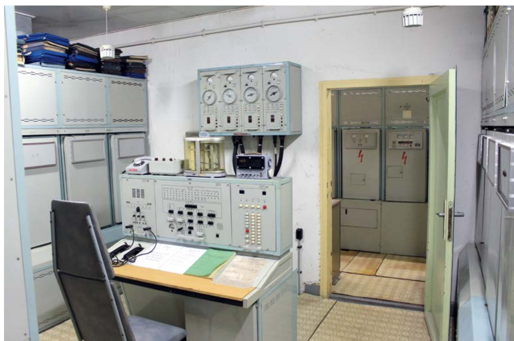
3. ÁBRA. Az északi irányú R-417Sz „Baget” troposzféra-rádióállomás vezérlőpultja. A szemben lévő falon láthatók a négy antenna irány- és dőlésszögének beállítókapcsolói és kijelzőműszerei. A nyitott ajtó mögötti helyiségben található az adók szekrényei (A szerző felvétele)
