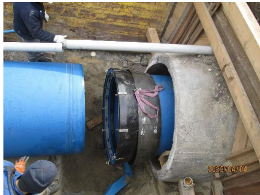
1. ábra: Csővonat behúzás előkészítése
