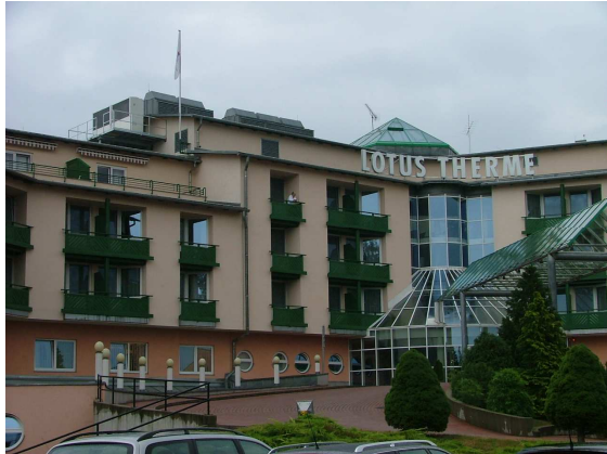
1. kép: A hévizi 2 db 56 kW hűtési teljesítményű földgáz motoros klímaberendezés távoli fotója Forrás: Regale Klímatechnika Kft.
