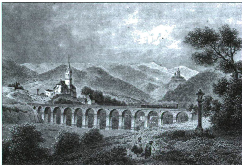
A Sopron–Bécsújhely közötti vasútvonalon Nagymartonnál épült Európa egyik legjelentősebb – 250 méter hosszú, húsz fonyílású – viaduktja. Tervezte Matthias Schönerer. Rohbock Lajos litográfiája, 1860
