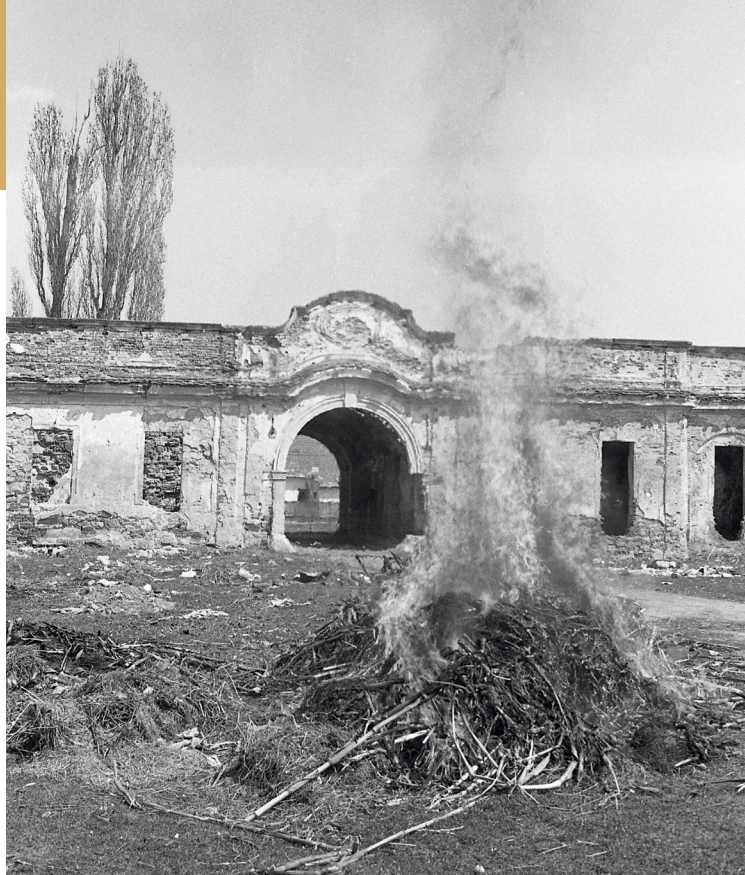
A kapuépület belső homlokzata az 1990-es években
