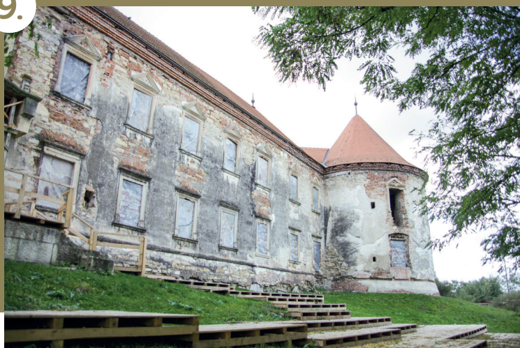
Fațada principală nordică a castelului, 2019
